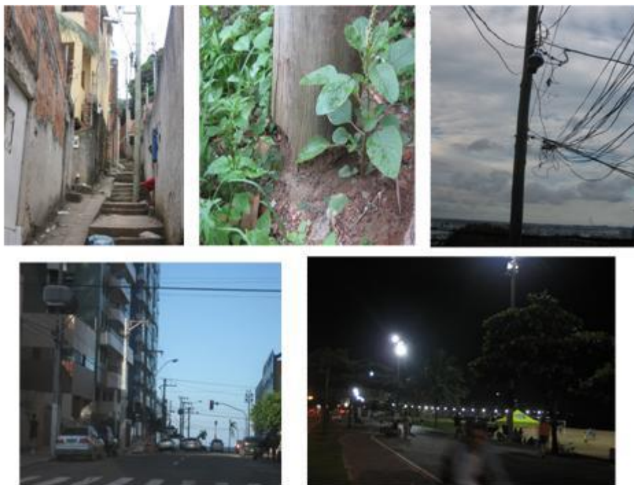
Figure 3 : L'état du réseau dans les deux quartiers
